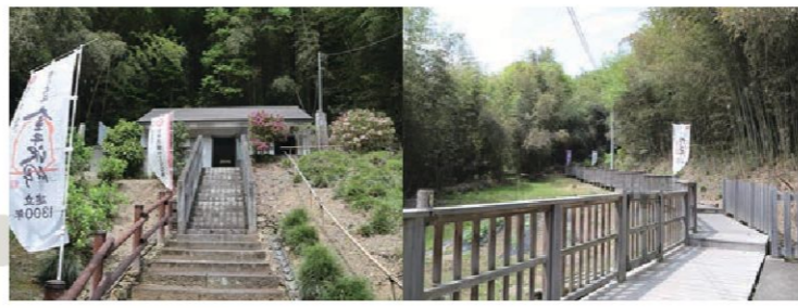
遊歩道と石段を登ったところにある金井沢碑の覆屋
